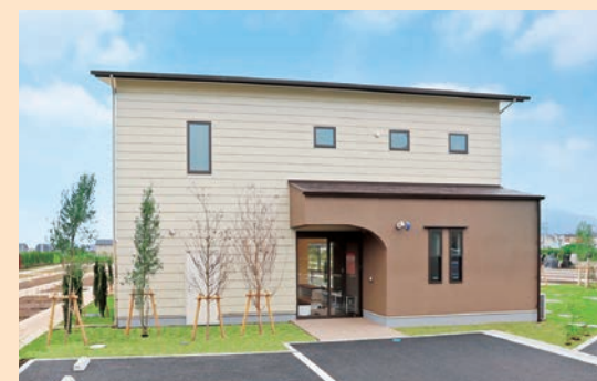
エレベーター付2階建ての管理棟
